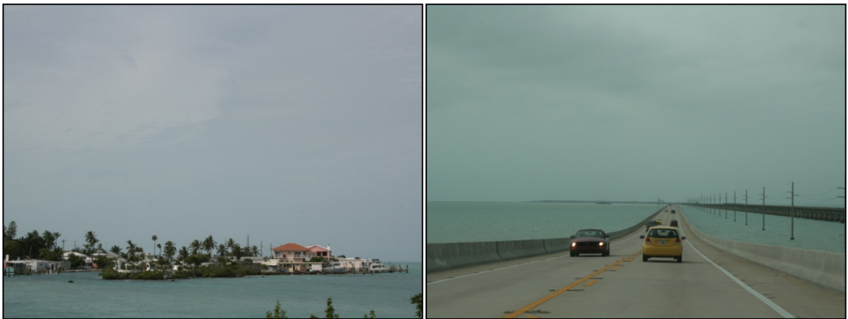
Vues sur une des îles et un des nombreux ponts les reliant
